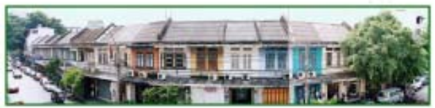
รูปแสดงอาคารบริเวณหน้าป้อมพระสุเมรุก่อนการปรับปรุงทาสี
