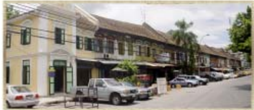
ภาพแสดงก่อนการปรับปรุงทาสีอาคารบริเวณริมถนนอัษฎางค์
